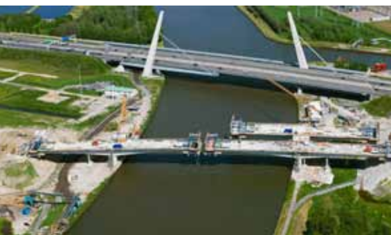
1.2 Nieuwe Betlembrug bij Muiden over het Amsterdam-Rijnkanaal. Ook tijdens de bouw moet een constructie in evenwicht zijn.
