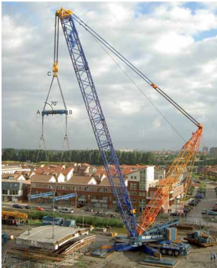
2.34 Inhijsen van een (op locatie gestorte) betonnen brug over een singel in een woonwijk in Capelle aan den IJssel.
