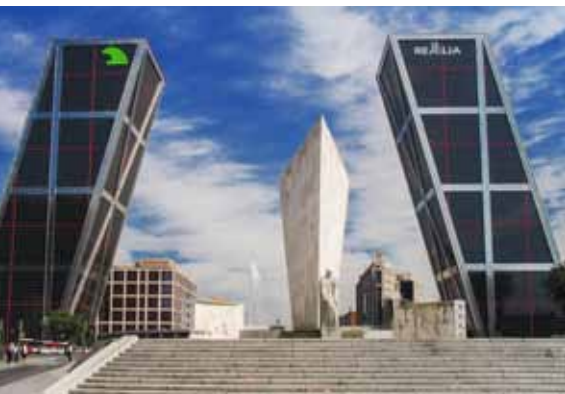
1.1 De beide kantoorgebouwen Puerta de Europe in Madrid staan onder een hoek van 15° en zijn elk in evenwicht.
